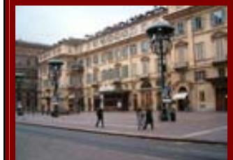
foto 2 - La facciata del Teatro Carignano di Torino
