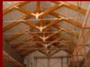
foto 10 – Le nuove capriate lignee del complesso monumentale di San Lorenzo ad Septimum per le aule da disegno della Facoltà di Architettura
