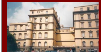
foto 5 - Uno dei padiglioni del I Policlinico interessati dall'intervento
