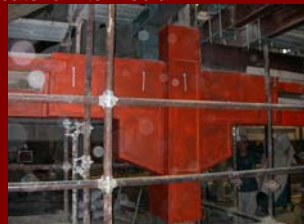
foto 9 - Lo stesso nodo nel corso delle lavorazioni
