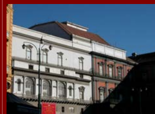
foto 8 – La copertura del Teatro di san Carlo in Napoli interessata dall'intervento
